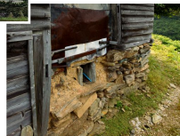
古い形態のムッシャは室内に炉があり、床下(地下)から通風するための焚き口があるのが特徴だ。▶
